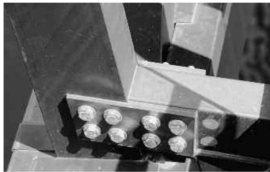
Ein weiterer Vorteil des Materials ist, dass die Brückenteile verschraubt werden und somit auf Schweißverbindungen vorwiegend verzichtet werden konnte. Da jede Schweißnaht eine Schwachstelle darstellt, kommt die Konstruktion bei tragenden Brückenteilen sogar ganz ohne diese aus.
